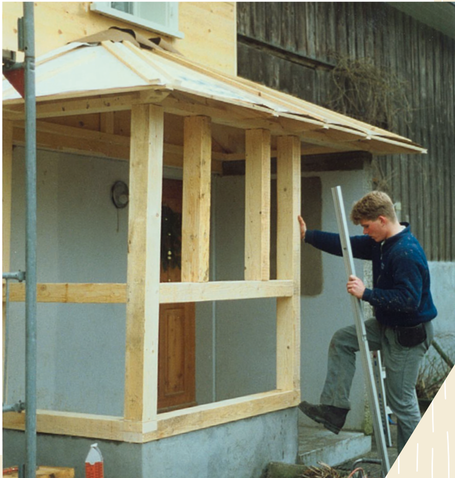
Im Element: Ralph Weber im 3. Lehrjahr als Zimmermann im elterlichen Betrieb.
