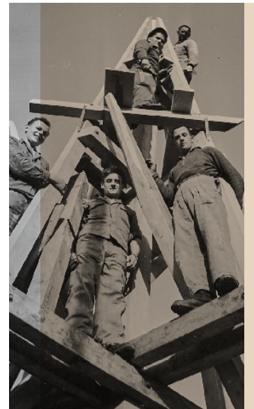
1955: Bau evangelischer Kirchturm in Kirchberg
