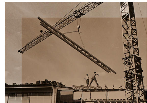
Aufrichtung Schulhaus Sonnenhof in den 60er-Jahren
